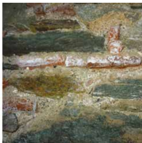
Εικ. 2. Ρηγματώσεις παλαιών υλικών και υλικών επέμβασης
