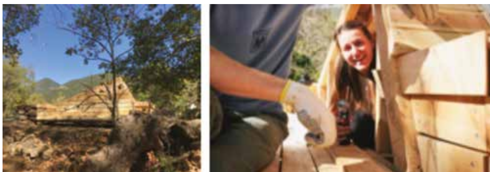
Εικ. 8. Η φάση σχεδιασμού και κατασκευής επί τόπου
