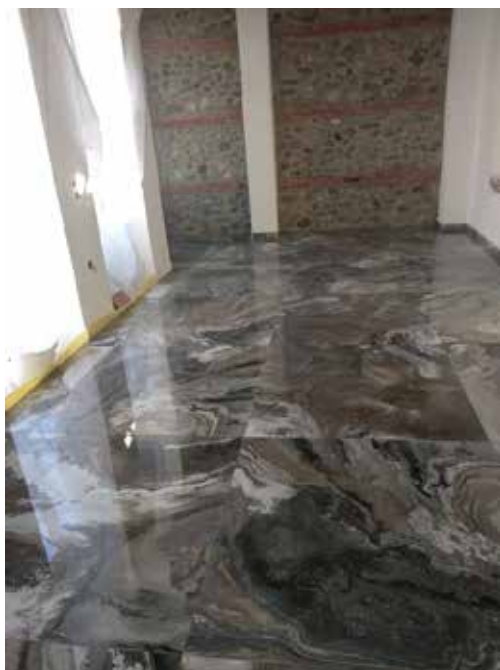
Εικ. 11: Εσωτερική άποψη του κοινόχρηστου χώρου (σαλόνι, τραπεζαρία, γραφείο) του ορόφου. Διακρίνεται το νέο πάτωμα με το πλακάκι και ο πέτρινος ξαναρμολογημένος τοίχος που θα υποδεχτεί τη νέα βιβλιοθήκη. Άποψη της κουζίνας.
