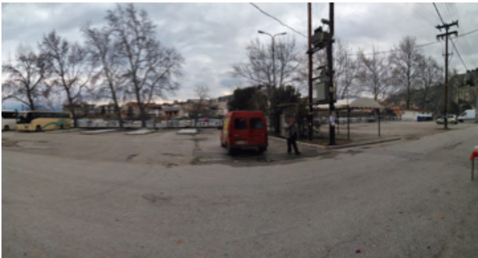
Εικ. 11: Κοινόχρηστος χώρος στάθμευσης επί της οδού Φιλίππου (κεντρικό τμήμα) και χώρος ΚΤΕΛ (Φώτο: Αρχείο Δ.Α.)
