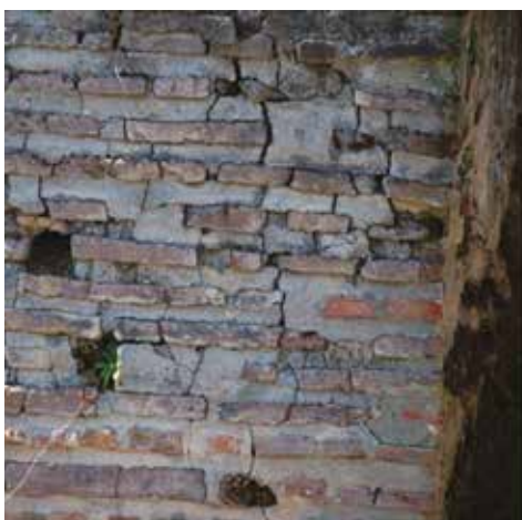
Εικ. 2. Ρηγματώσεις παλαιών υλικών και υλικών επέμβασης
