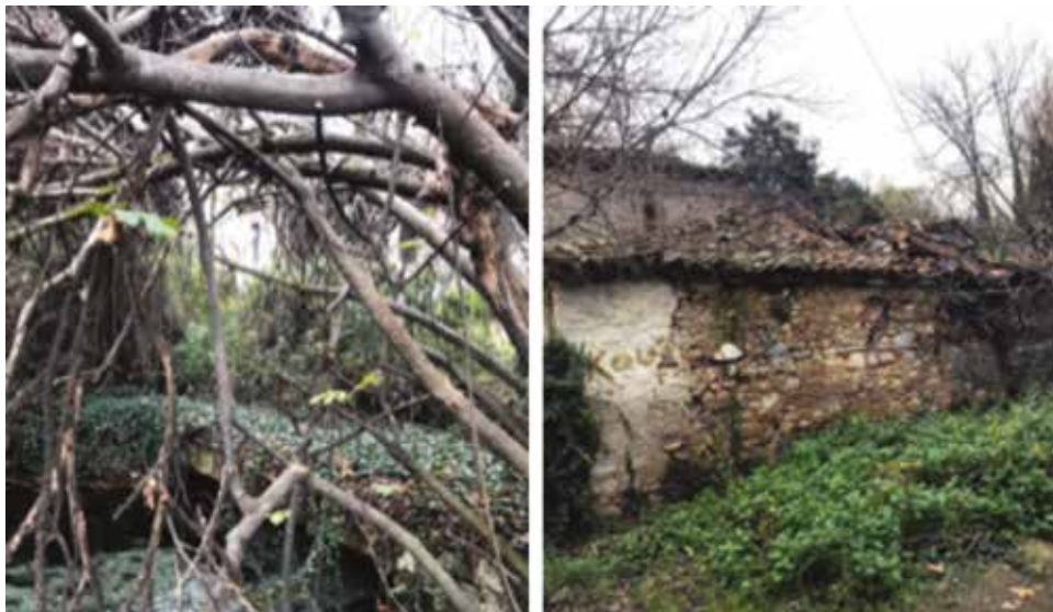
Εικ. 10,11. Λεπτομέρειες του υδρόμυλου Δημηρόπουλου και του περιβάλλοντα χώρου [πηγή: Ζαβράκα, 2019]
